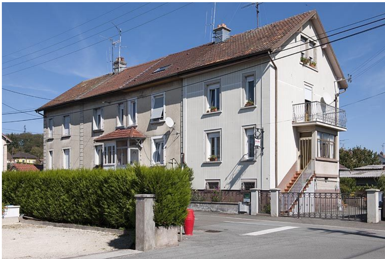
Immeuble rue du Maroc.
