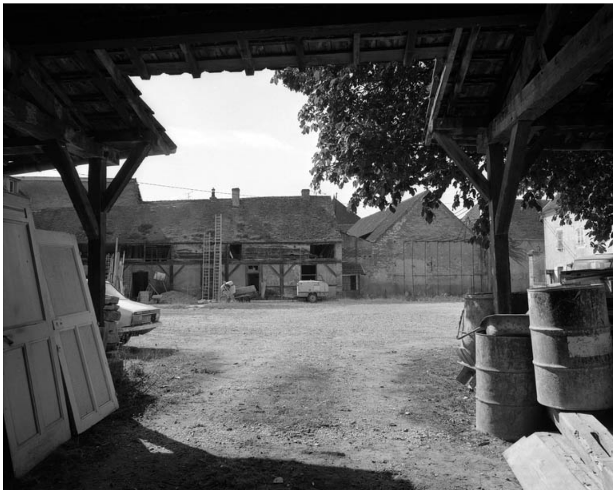
Bâtiments annexes à droite de la cour.
