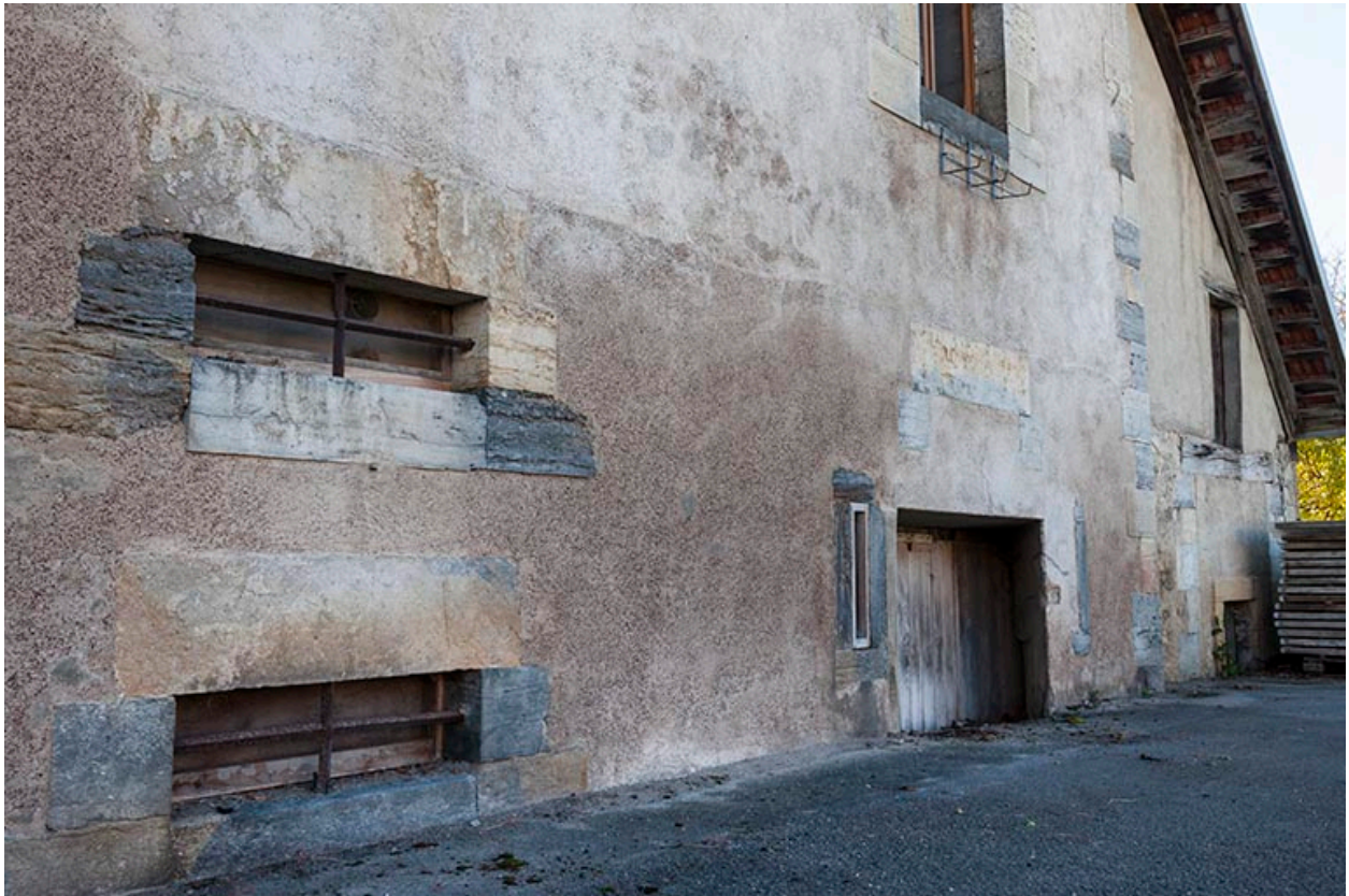
Ouvertures (caves d'affinage) sur la façade postérieure.
