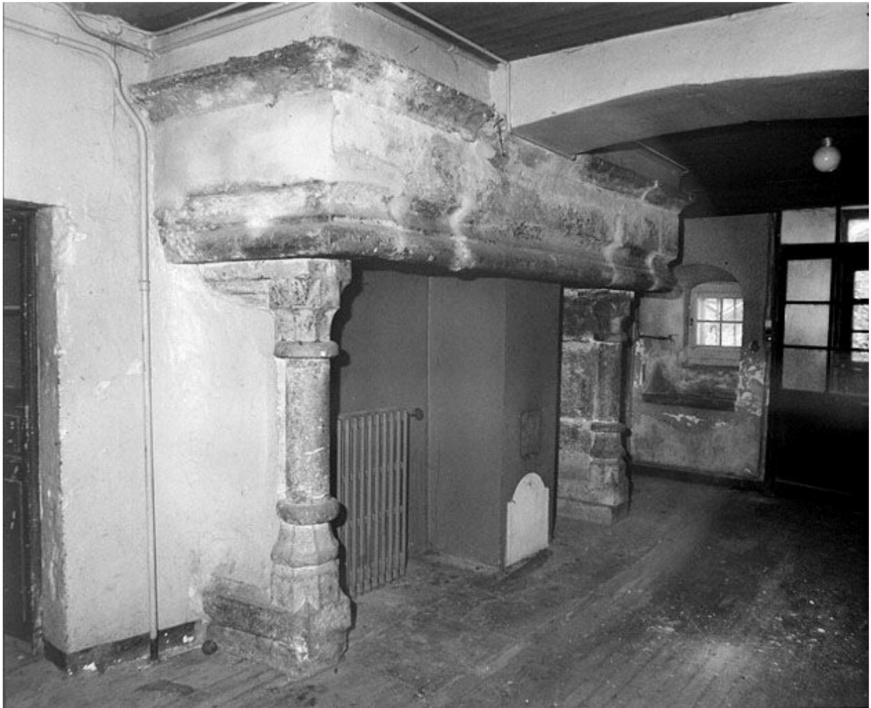
Vue intérieure, cheminée.
