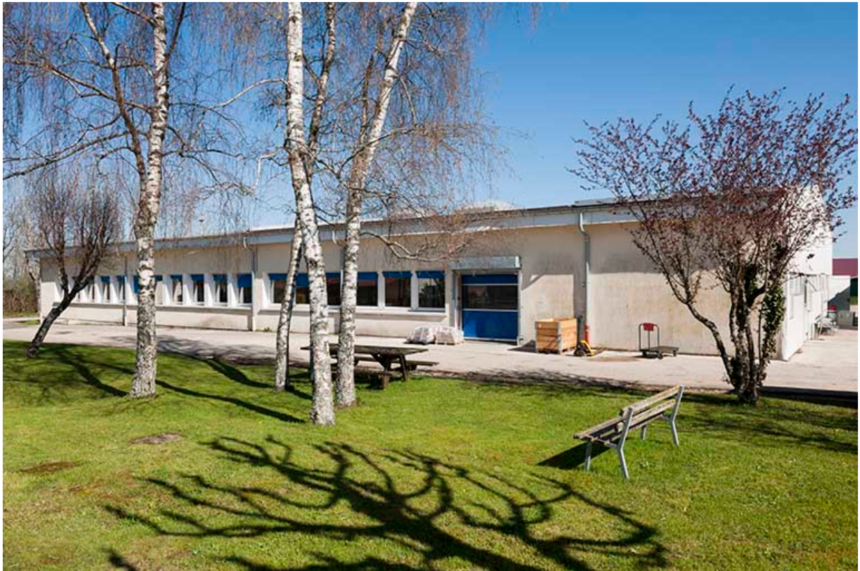
Vue depuis le sud-est.
