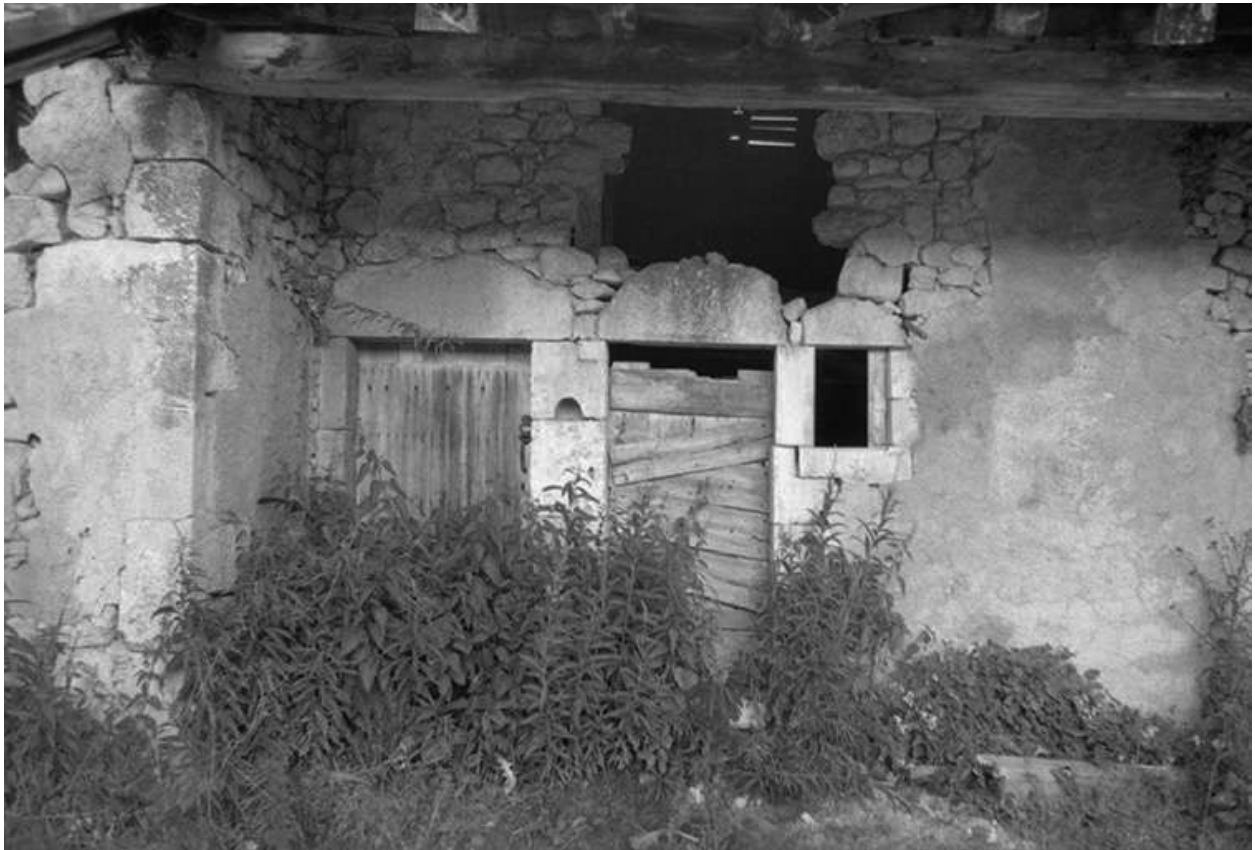
Porte d'entrée du couloir, porte d'entrée d'habitation.
