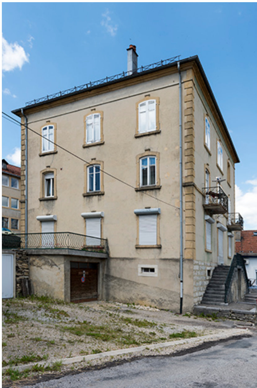
Façade latérale gauche, de trois quarts.
