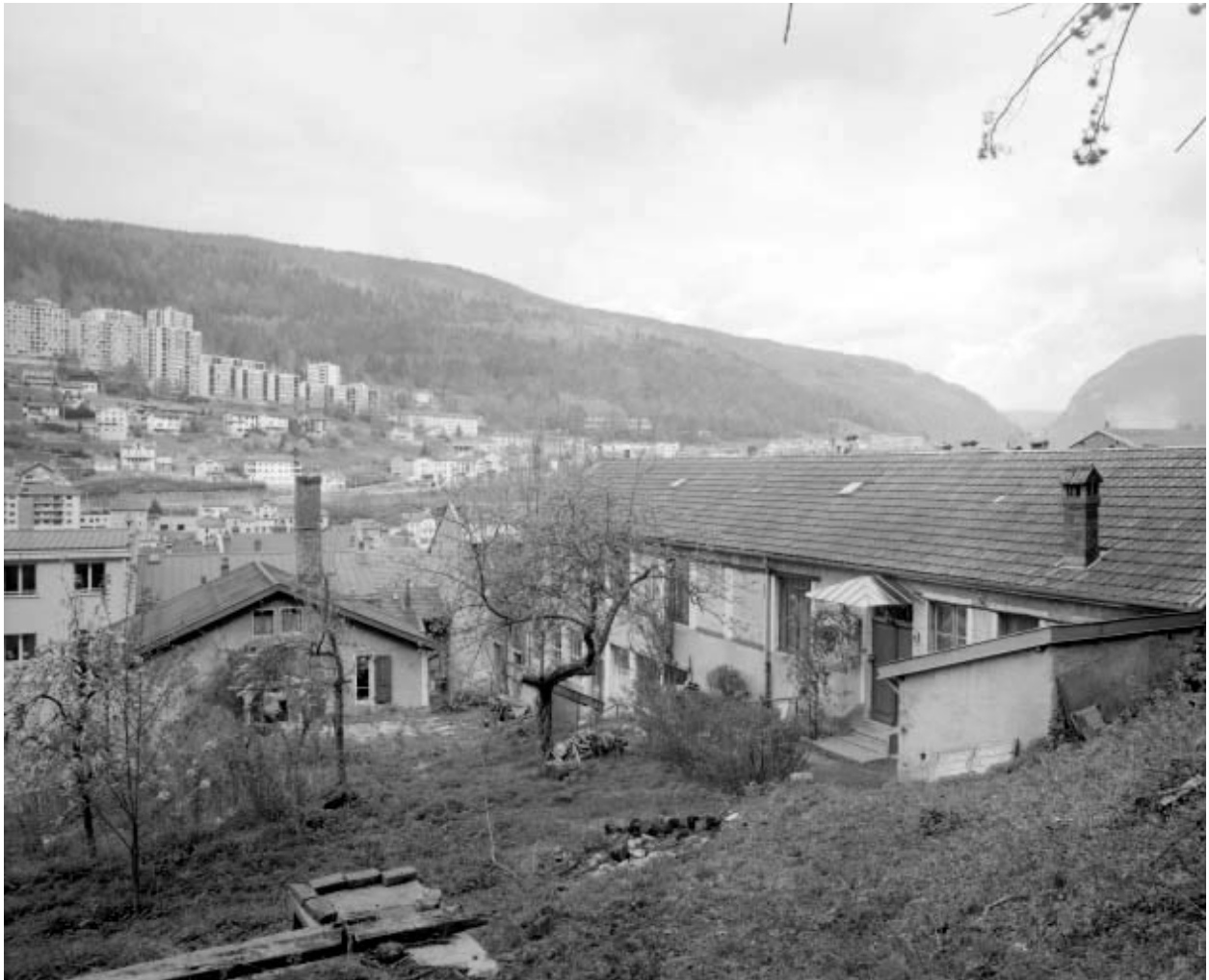
Bureau et atelier de fabrication depuis le sud.
