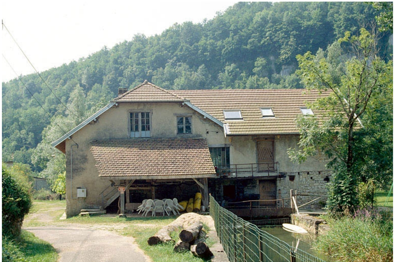
Moulin et tournerie, vus du nord.
