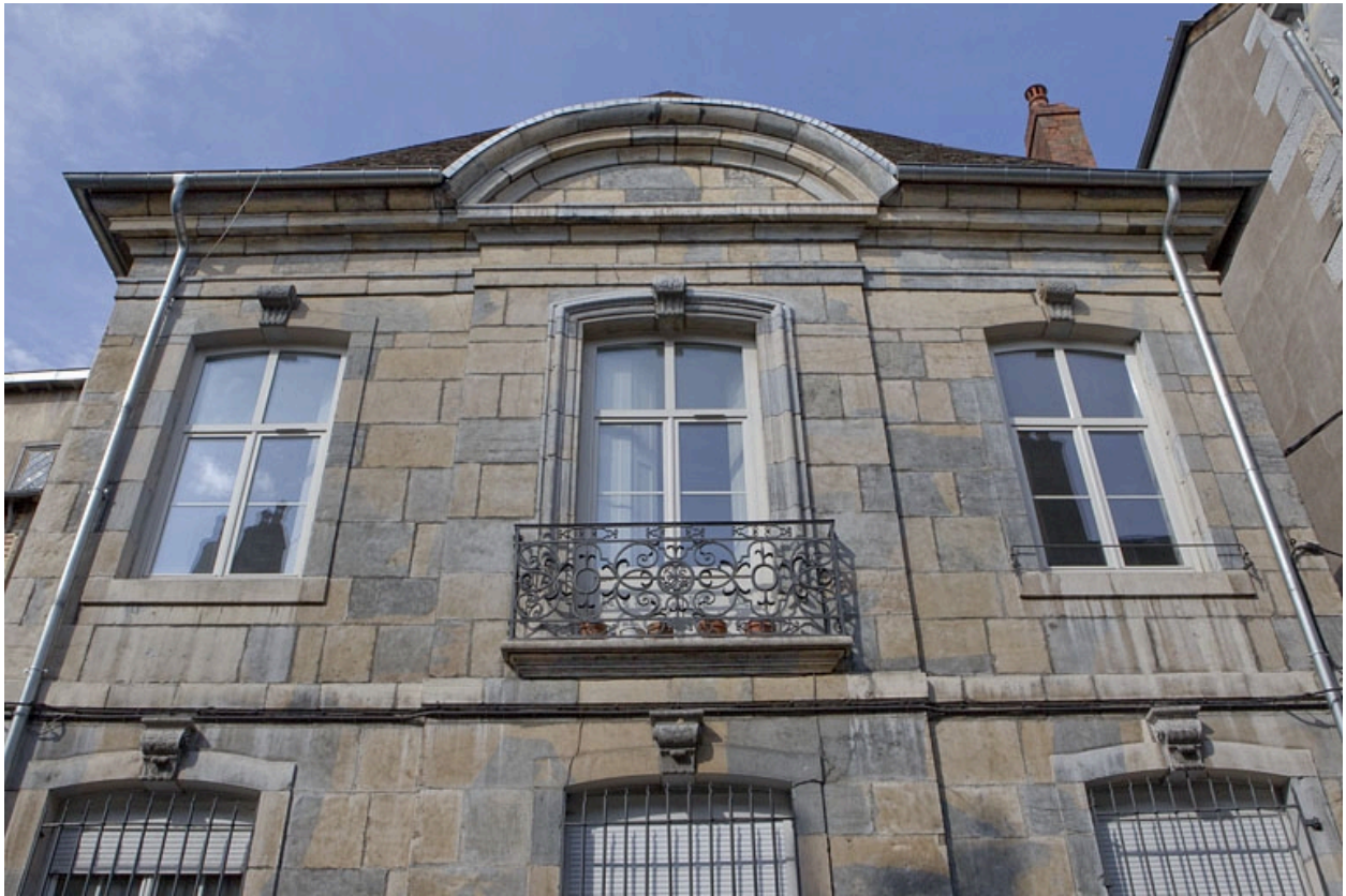
Aile droite : partie supérieure de la façade sur rue surmontée d'un fronton cintré.
