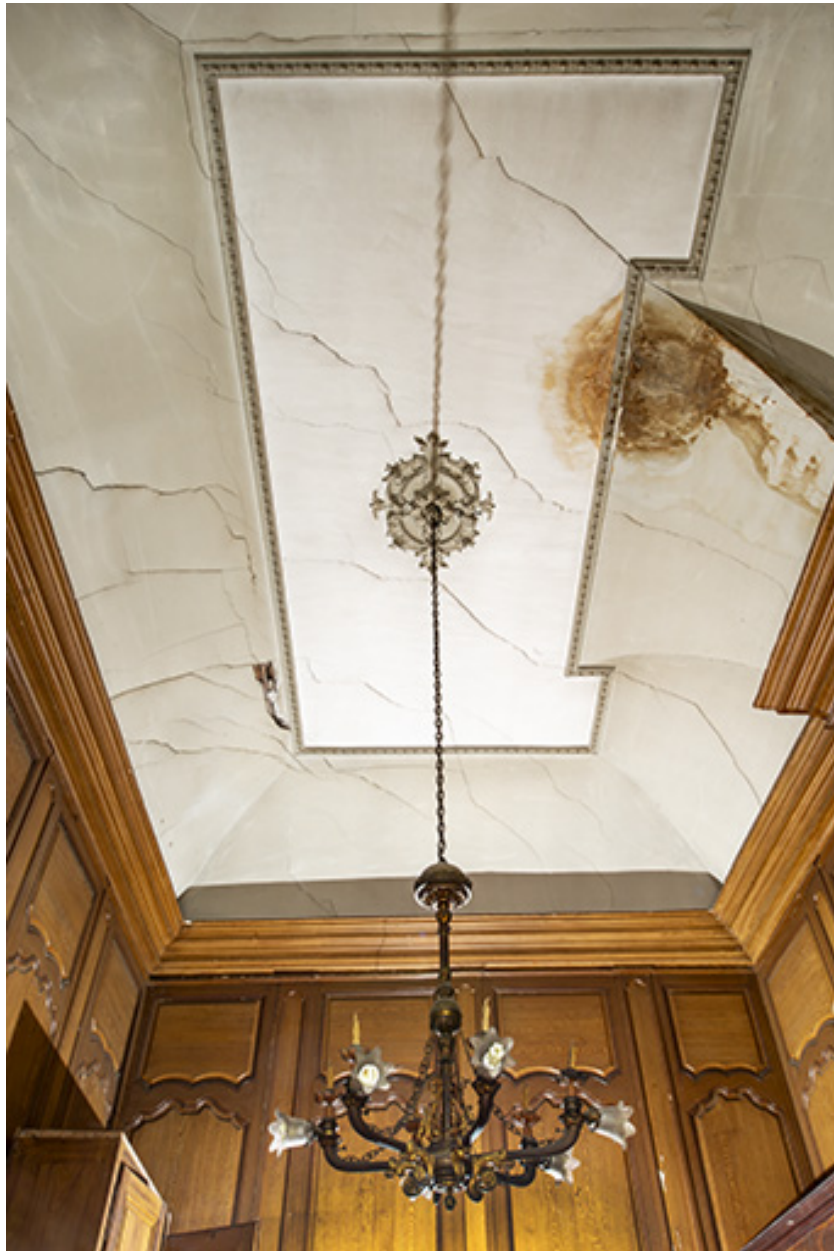
Plafond du bureau jouxtant l'ancienne salle du conseil.
