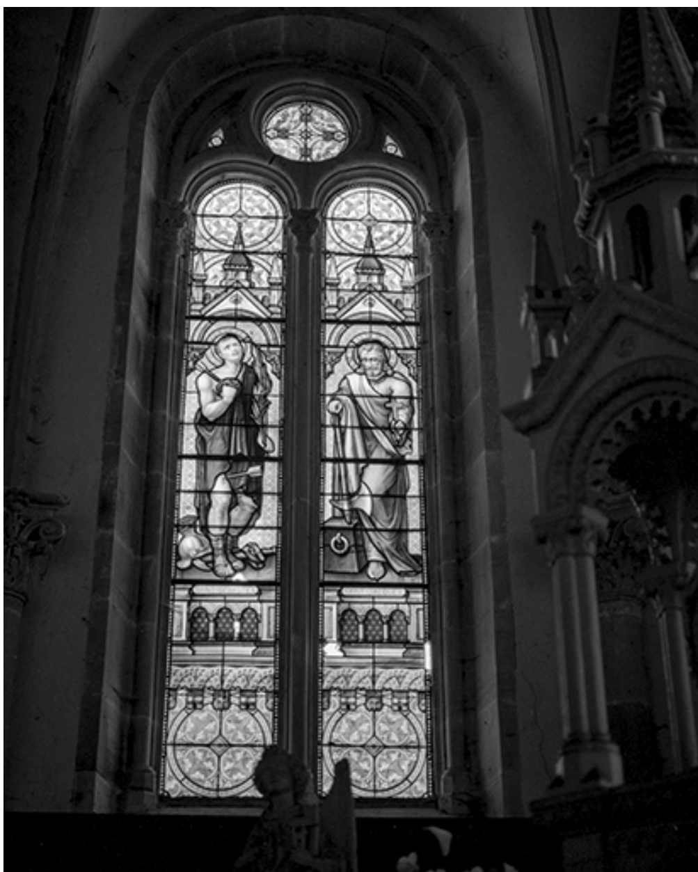
Baie 1 : vue d'ensemble.
