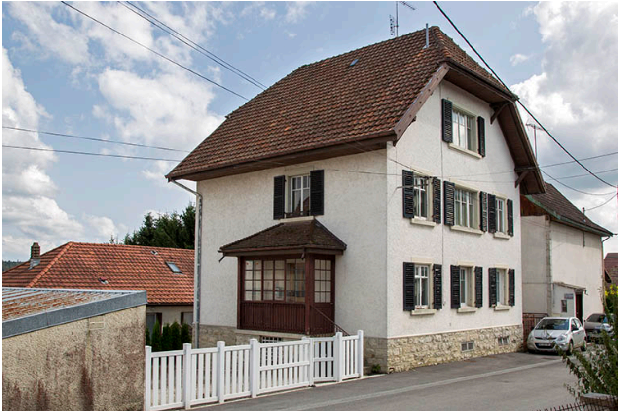
Vue d'ensemble, depuis le nord (façades antérieure et latérale gauche).
