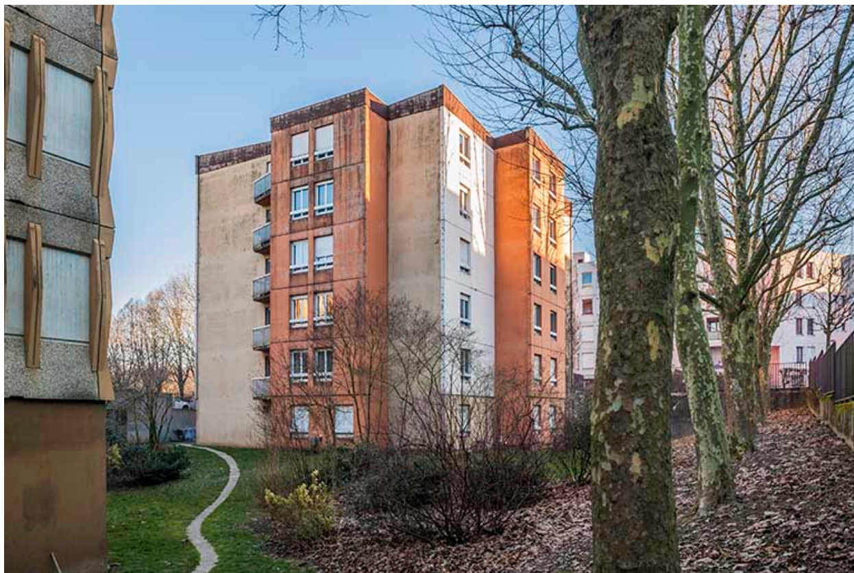
Angle sud des logements.
