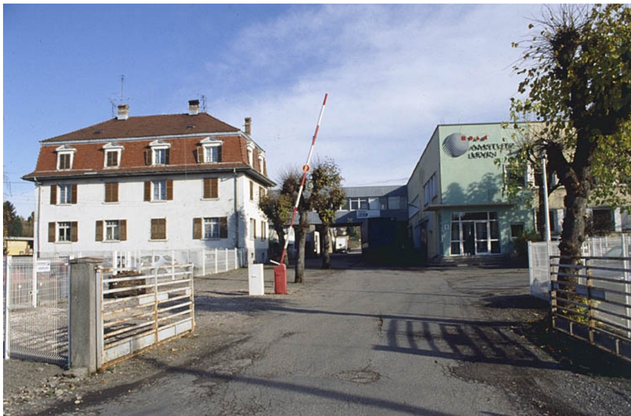
Entrée de l'usine.
