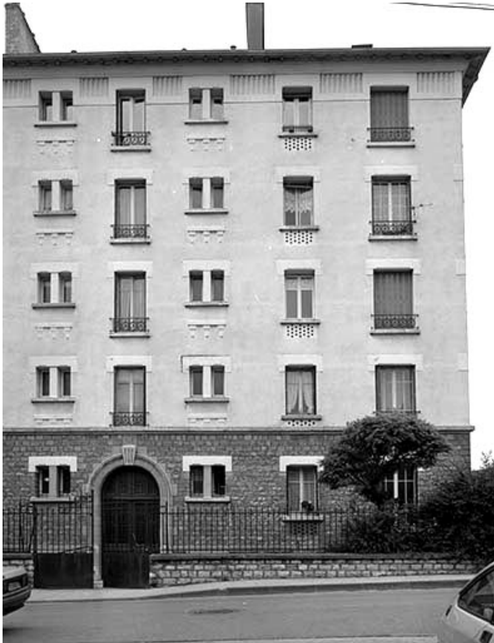
Détail de la façade de l'immeuble, 50 avenue Georges Clémenceau.
