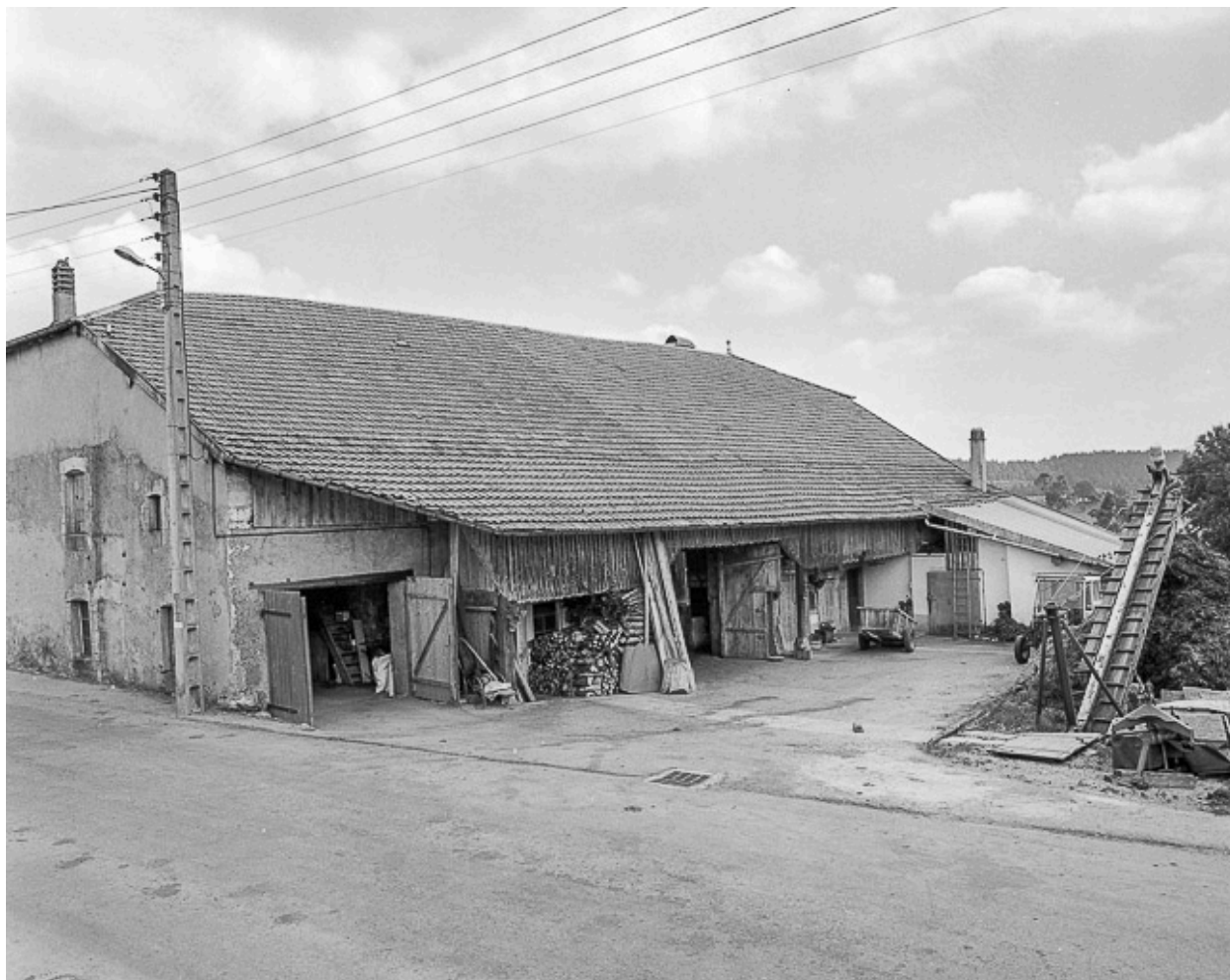
Mur goutterot d'une ferme.
