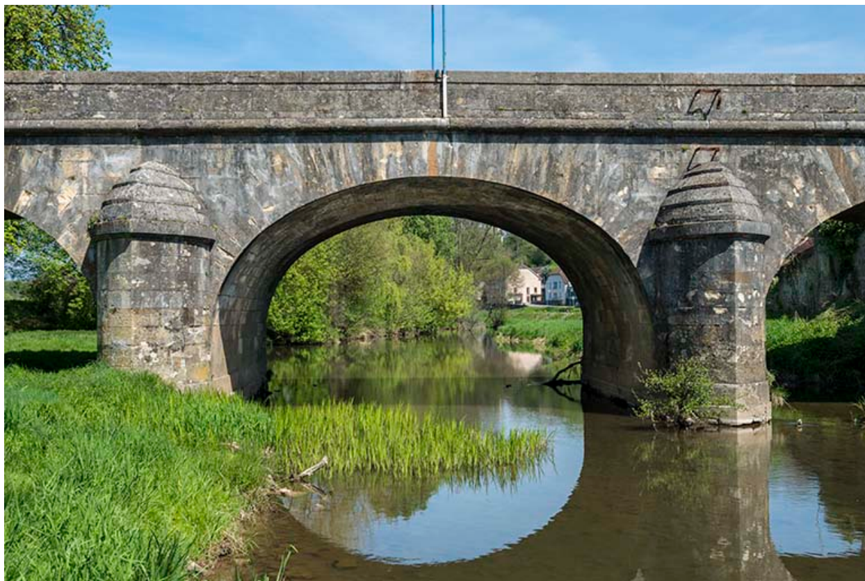
Détail de l'arche centrale.
