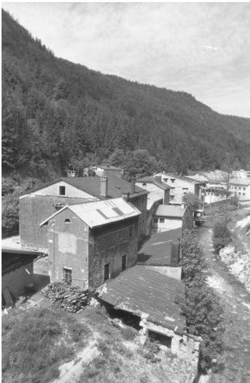
Vue d'ensemble depuis l'est (amont).
