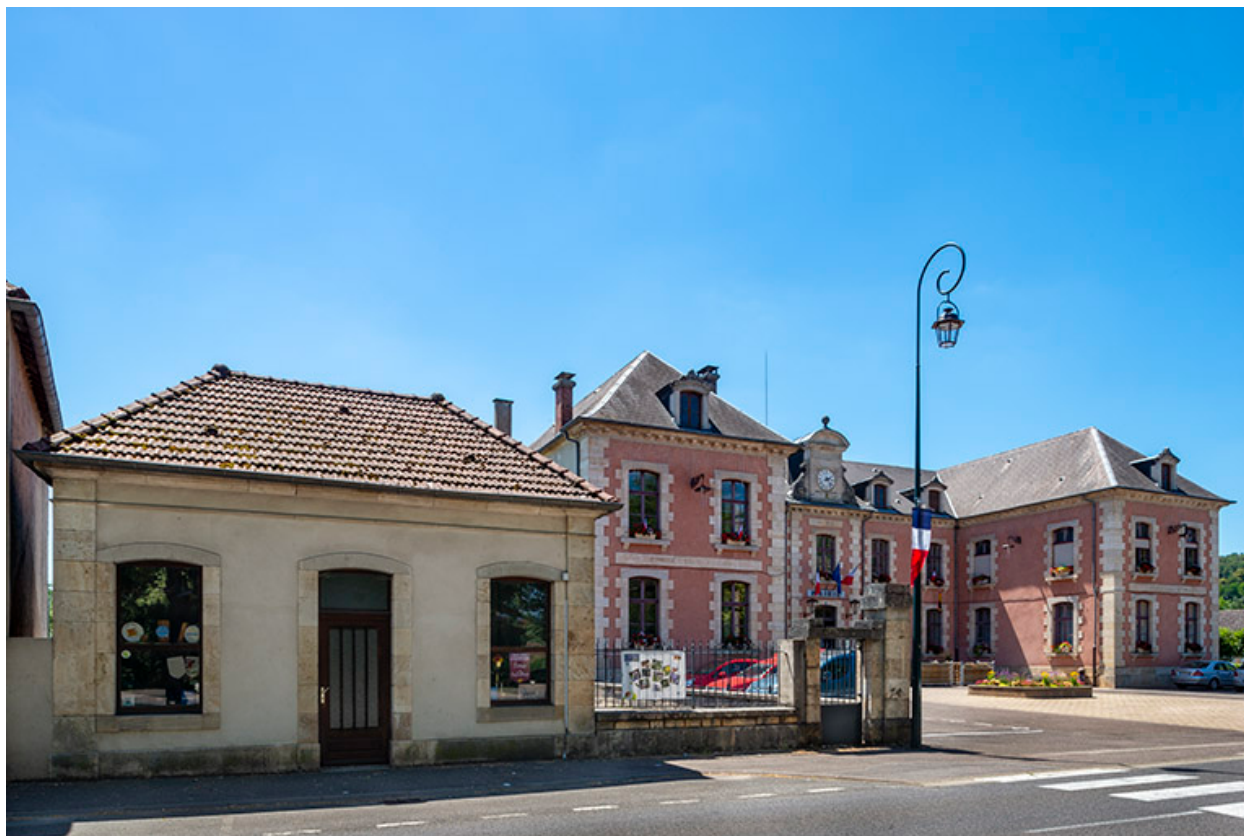
Corps de garde, sur l'avenue des Pâtis.
