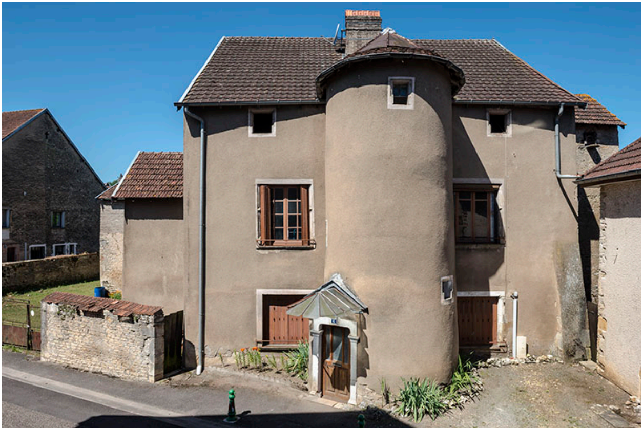
Élévation sur la rue André Bergerot, vue de face.
