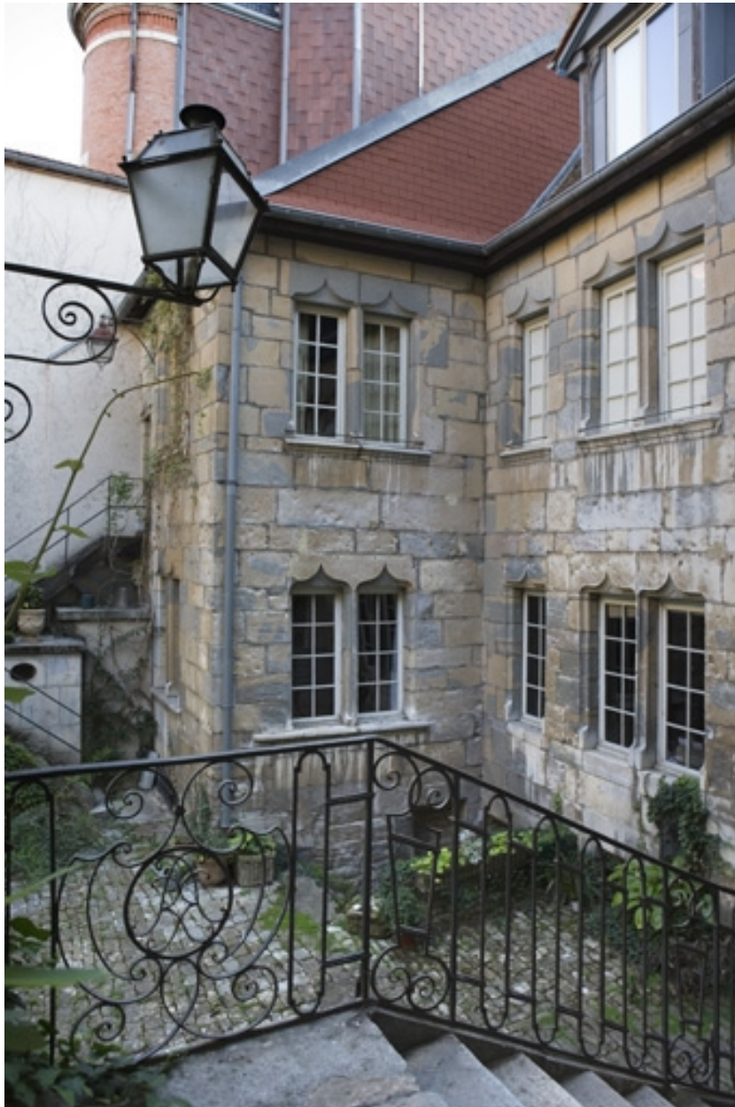
Façade postérieure du logis depuis l'escalier extérieur, de trois quarts droit.
