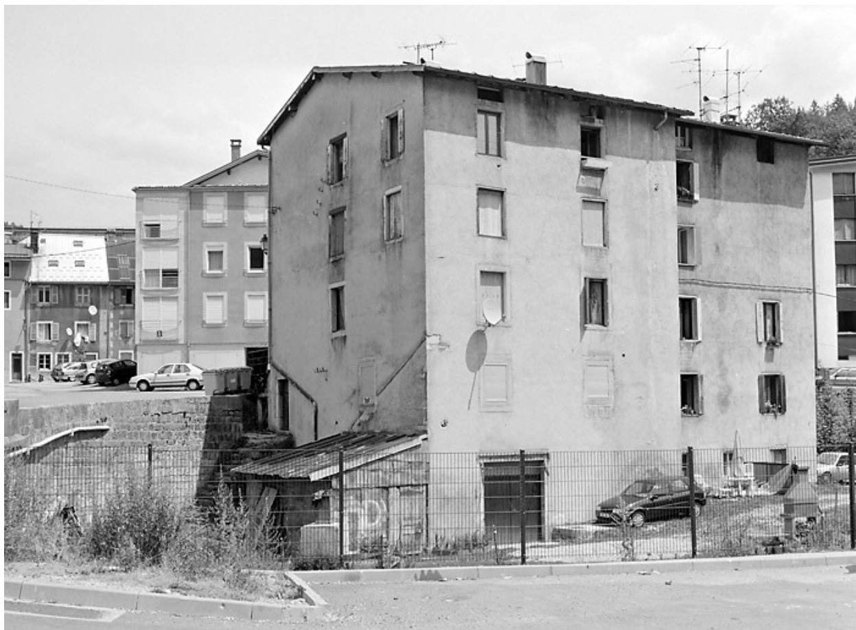
Elévation postérieure, de trois quarts gauche.
