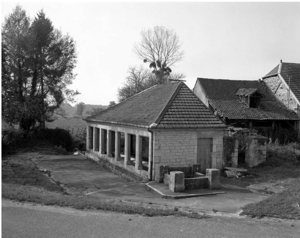
Façades postérieures depuis la cour en 1988.
