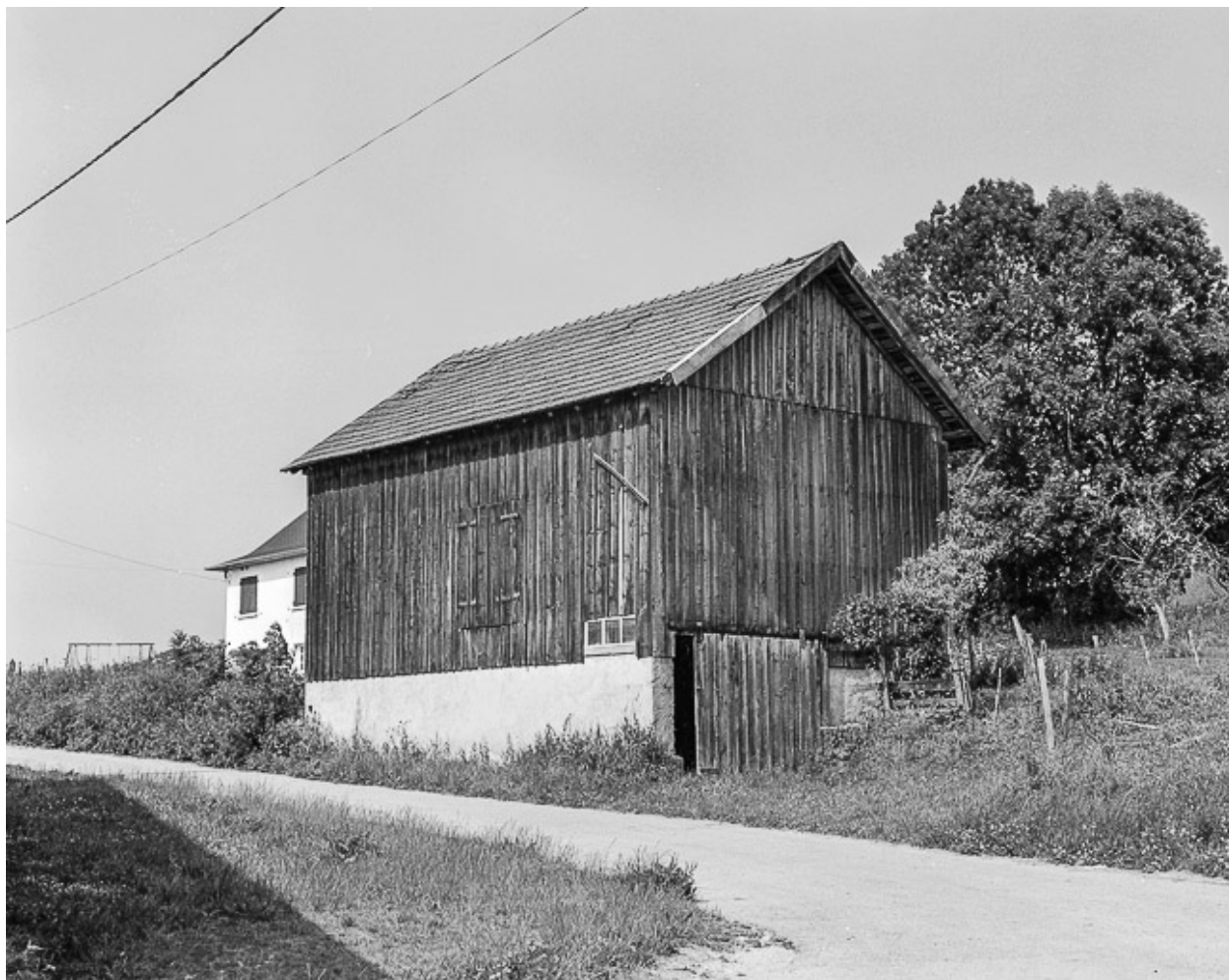
Remise cadastrée 1933 B1 94 : vue d'ensemble.
