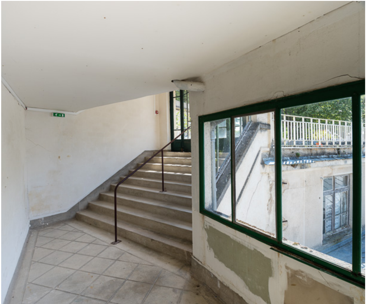
Vue intérieure en direction de la terrasse de l'hôtel.
