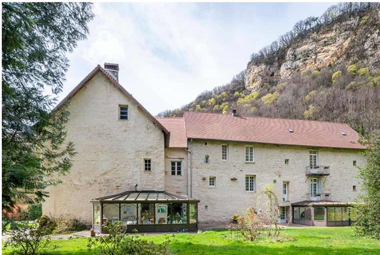
Façade nord des bâtiments.
