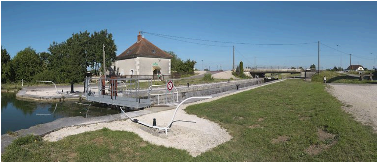
Site de l'écluse 59 du versant Saône, dite de Beauregard, à Longvic : vue d'amont.
