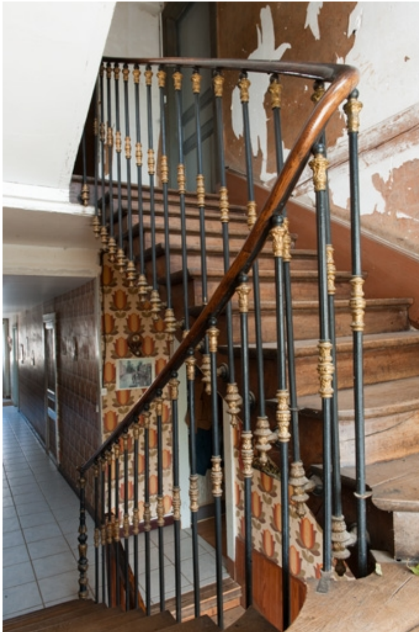
Intérieur du logis (côté rue) : escalier menant à l'étage des chambres.
