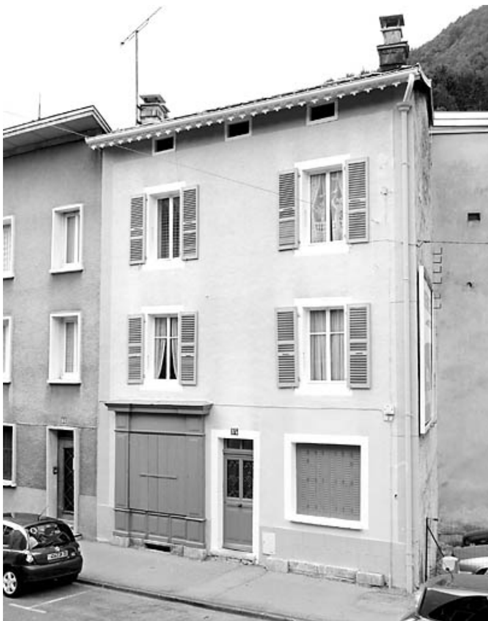
Façade antérieure de la maison.
