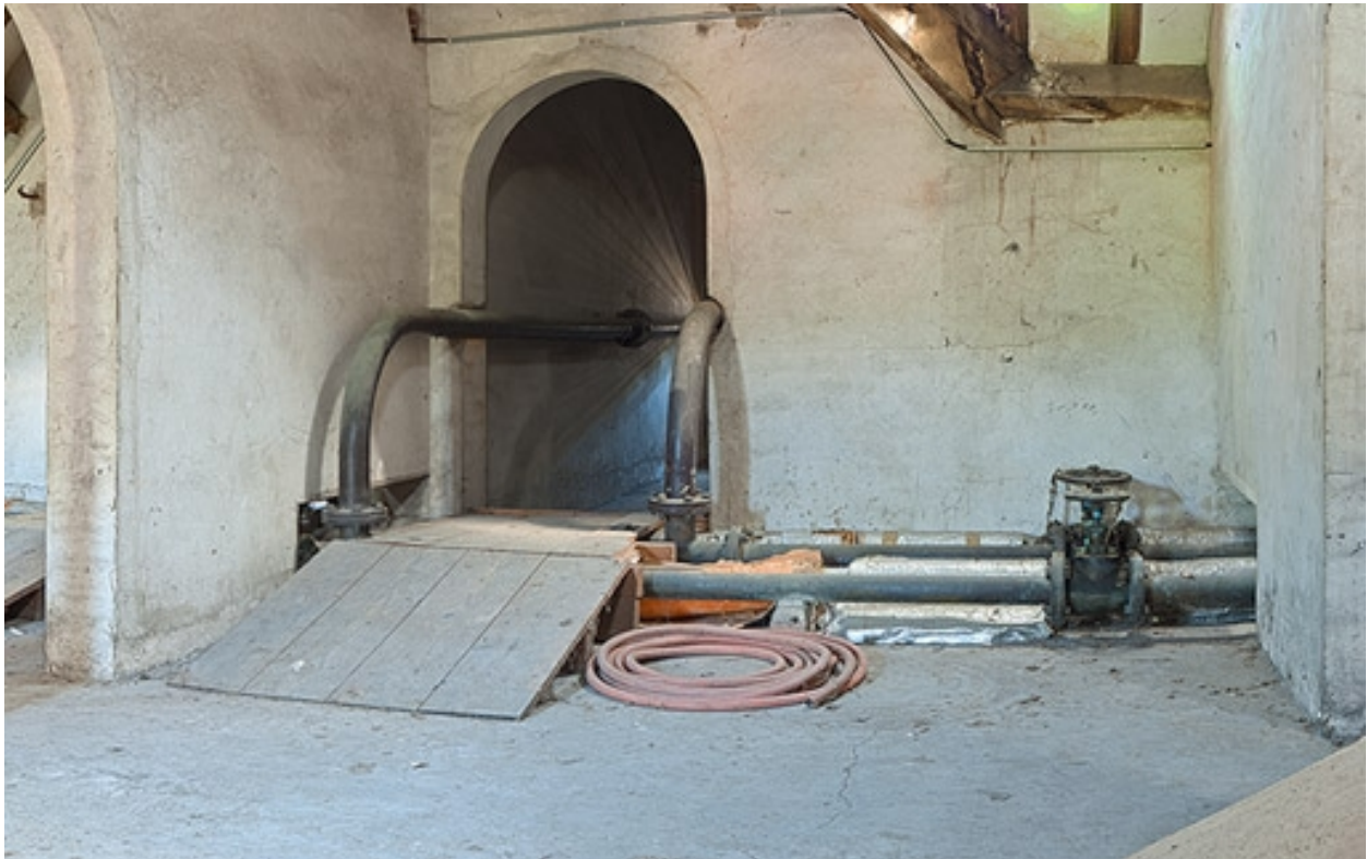
Comble : porte menant à l'aqueduc.
