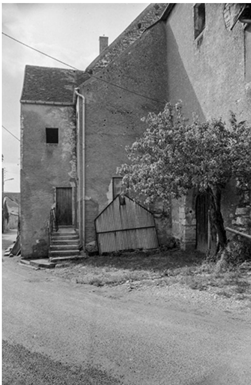
Façade rue des Châteaux, trois quarts gauche.
