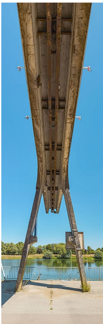
Portique de déchargement avec poulie.
