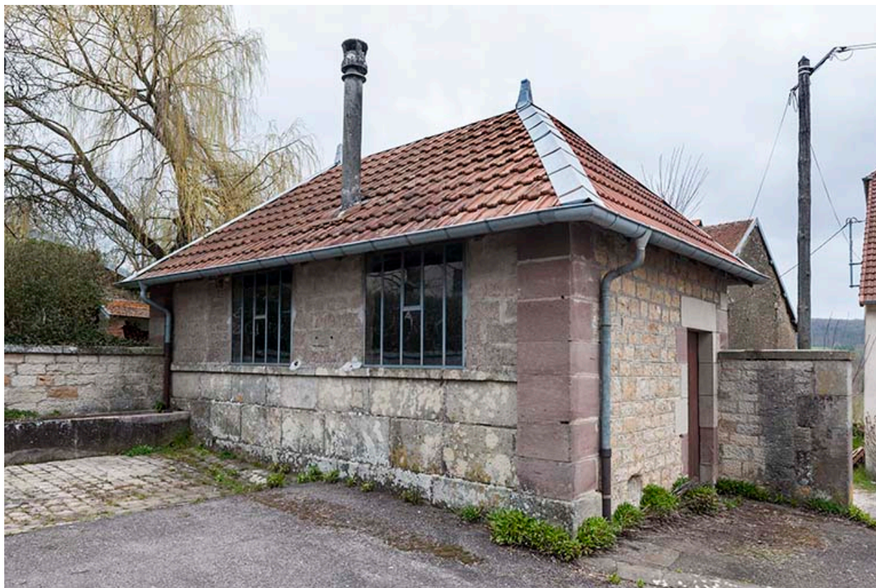
Le lavoir, transformé en local municipal.
