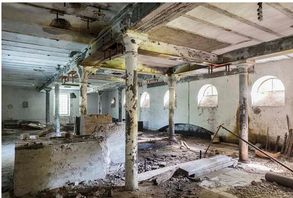
Atelier de fabrication (rez-de-chaussée). Partie est.
