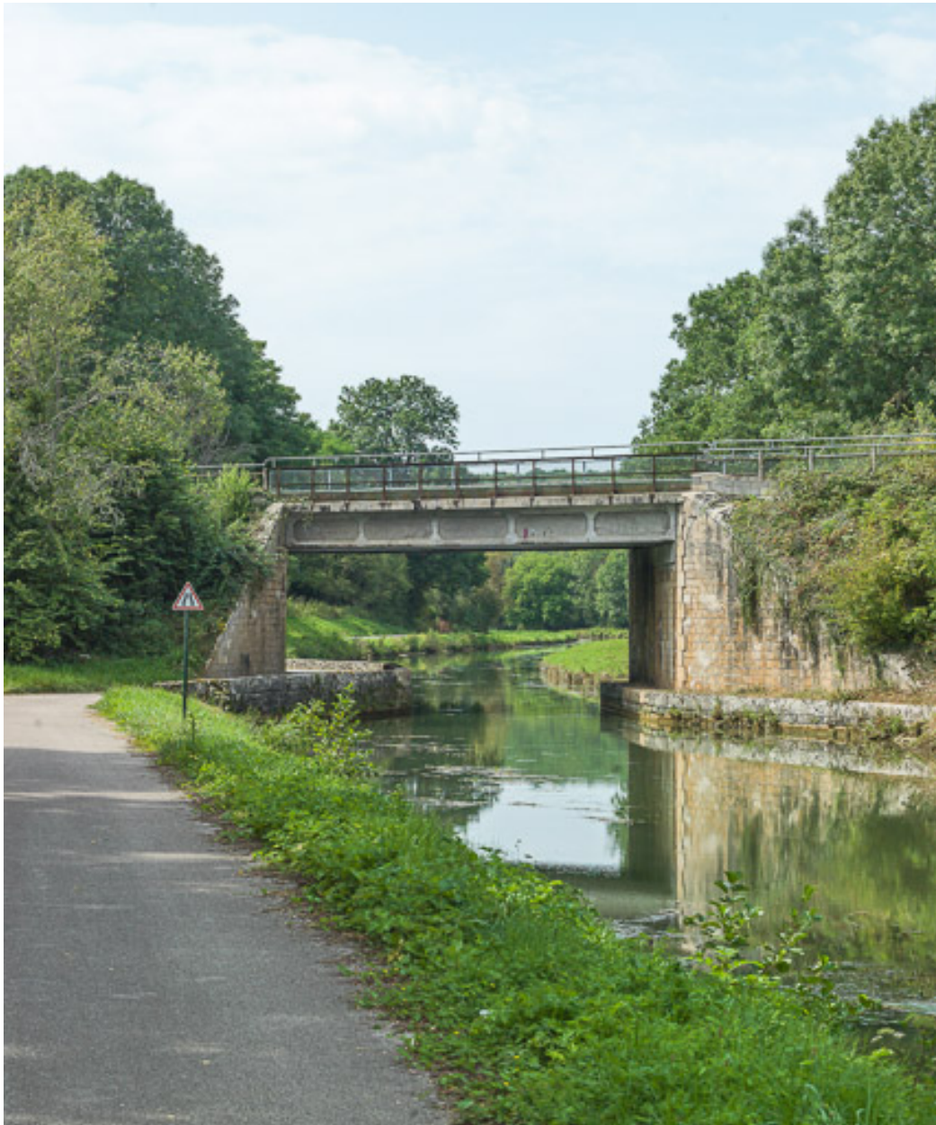
Vue d'ensemble du pont.
