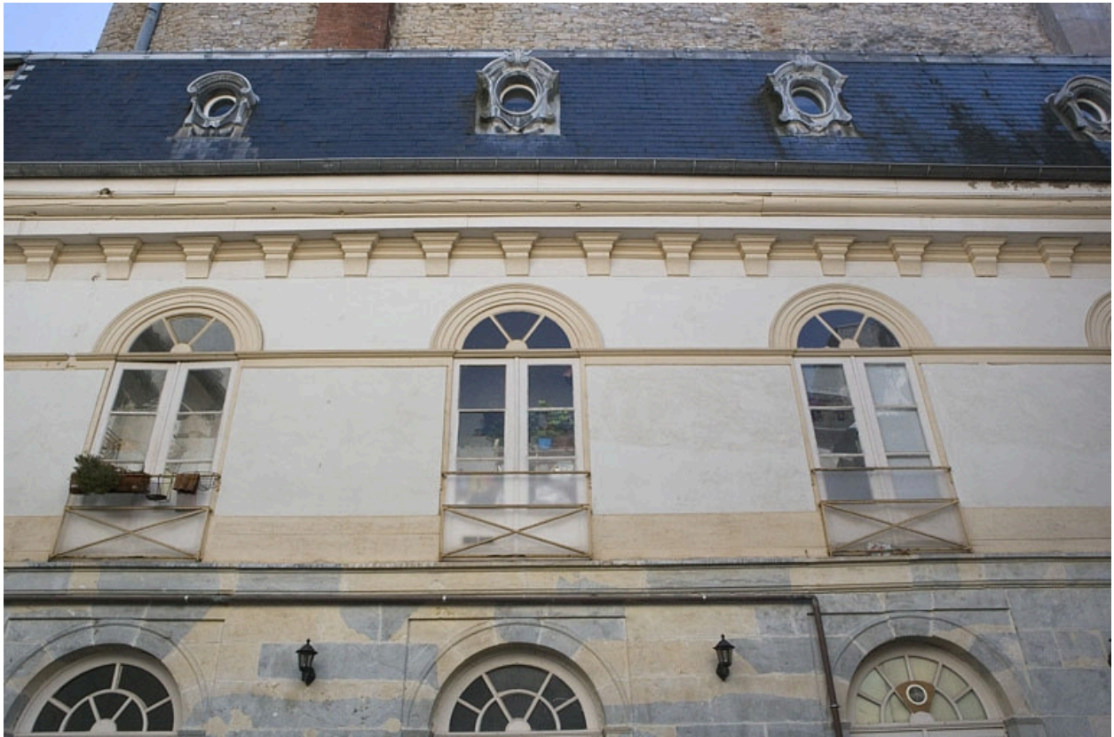
Détail du premier étage de l'aile sur cour.
