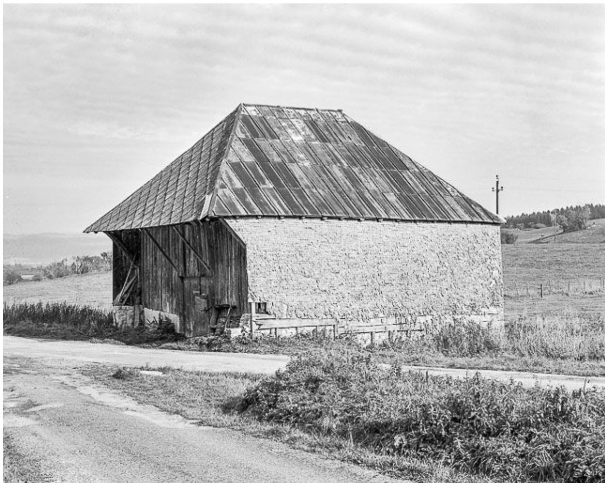
Bâtiment servant de remise.
