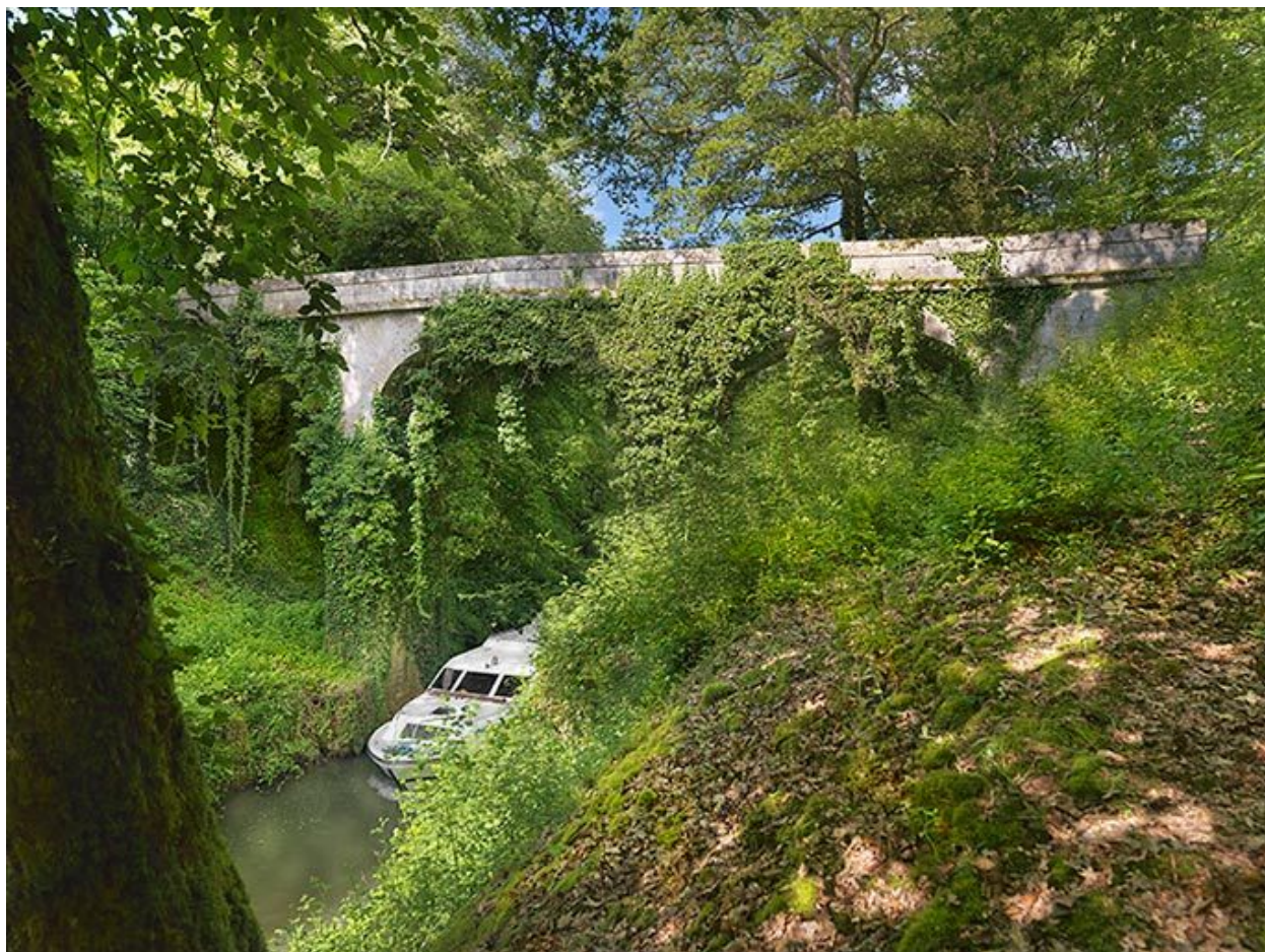
Vue d'ensemble du pont.
