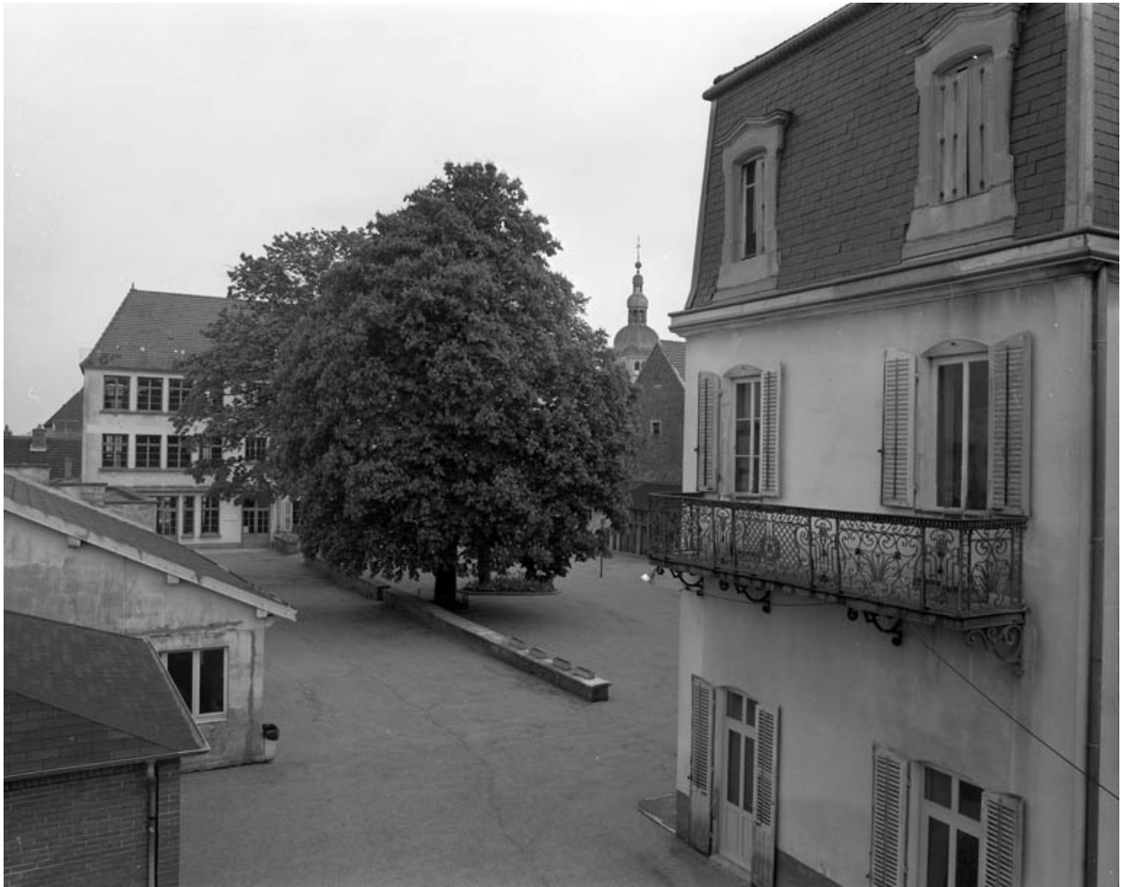
Vue d'ensemble de la cour depuis le fond de la parcelle.
