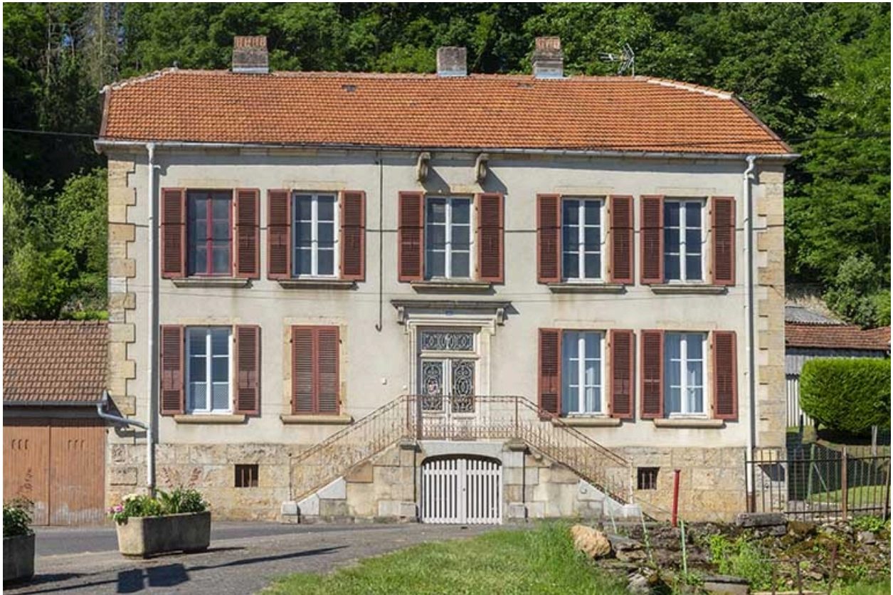
Rue Thiers, façade de la demeure n° 106.
