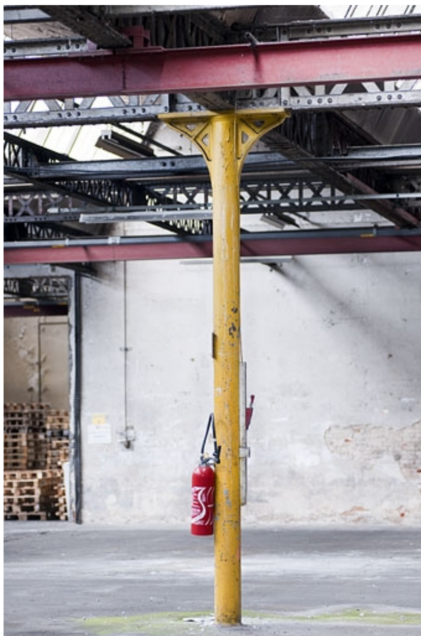
Colonne en fonte et charpente métallique.
