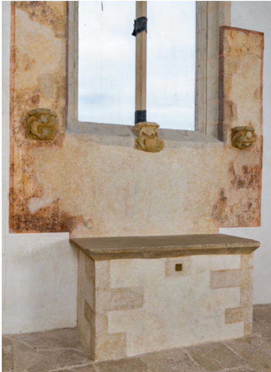
Mur nord de la chapelle.
