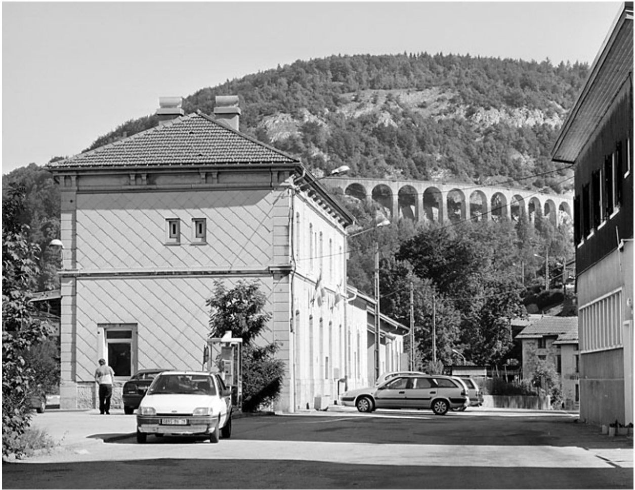
Bâtiment des voyageurs : façade latérale gauche.
