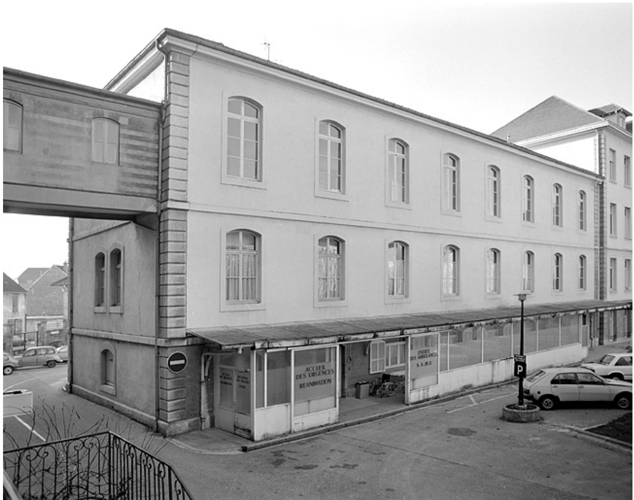
Bâtiment annexe (Pavillon sud) depuis la cour.
