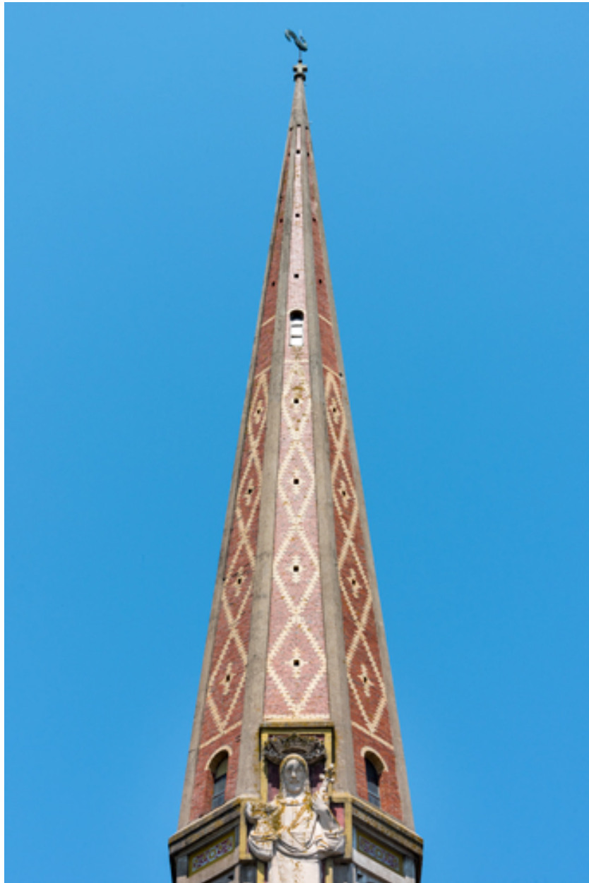
Toiture du clocher. Vue d'ensemble.
