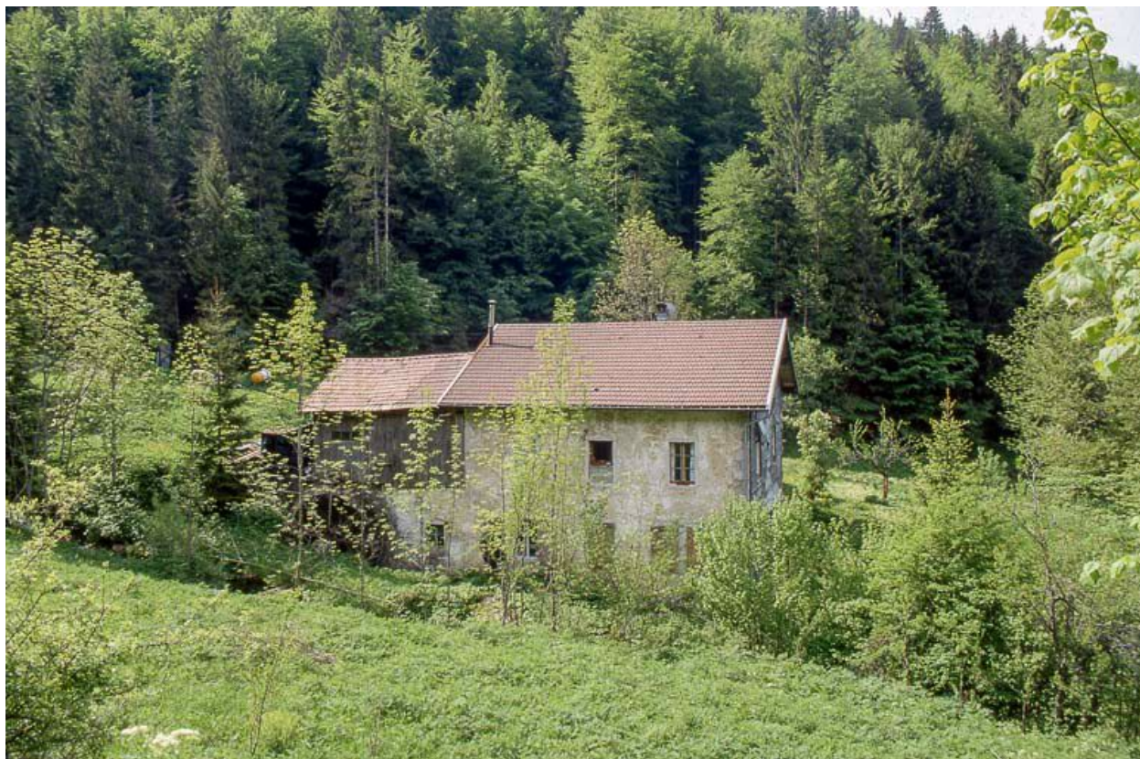
Façade postérieure, vue éloignée.
