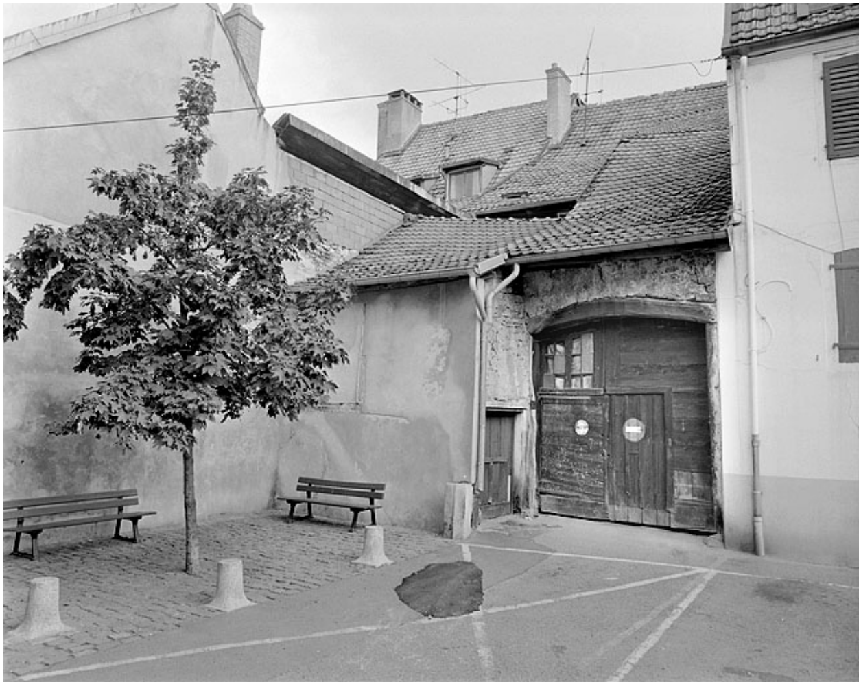
Façade sur l'impasse du Laquet.
