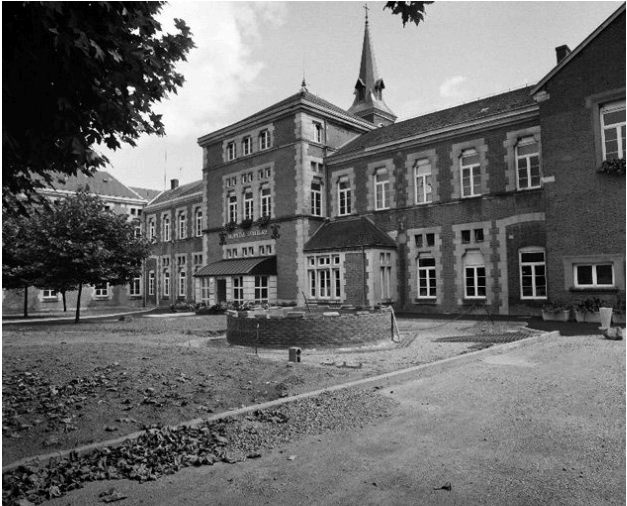
Façade postérieure de l'aile droite.
