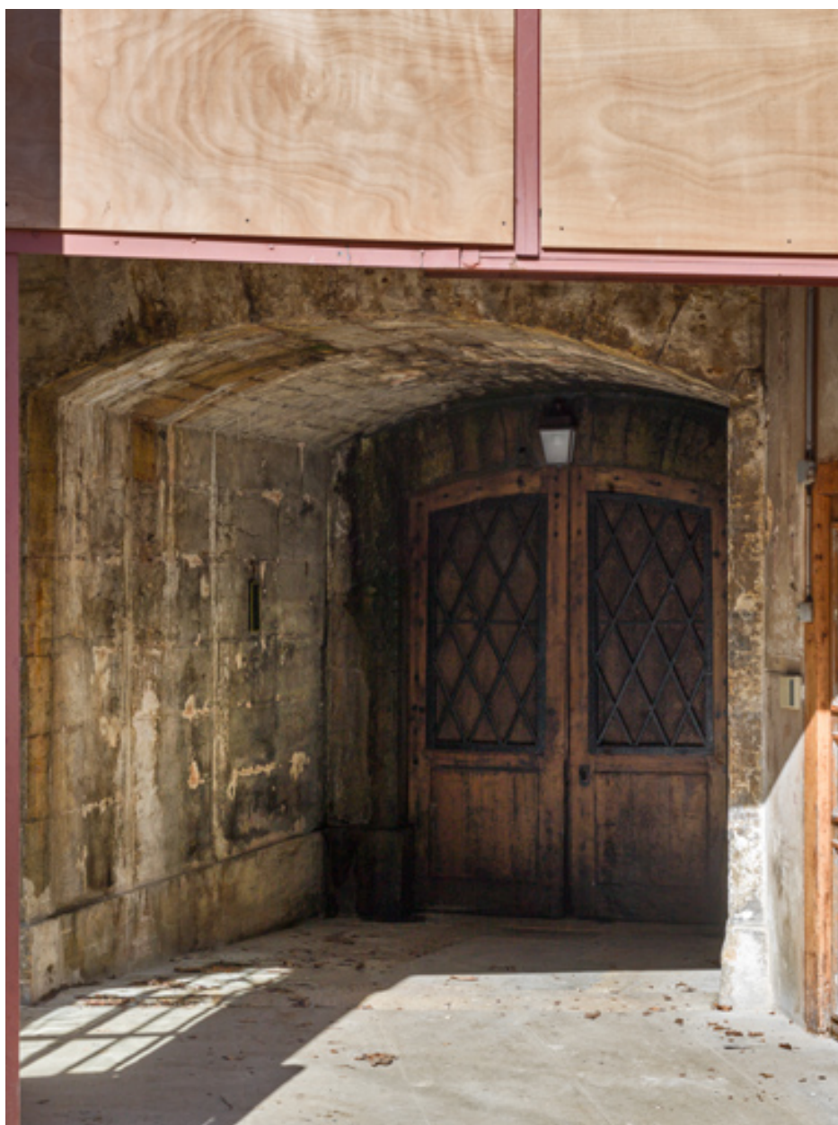
Entrée de la tour au rez-de-chaussée.
